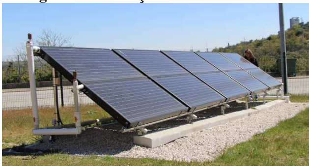
Figura 1: Instalação dos coletores PVTs
